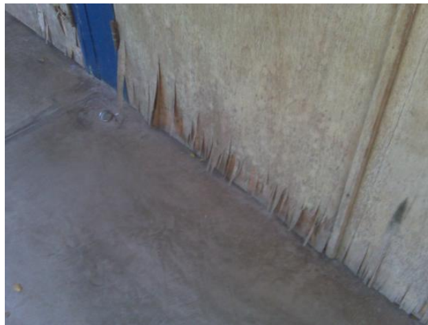
Figura 39. Puerta de Pabellón 2
