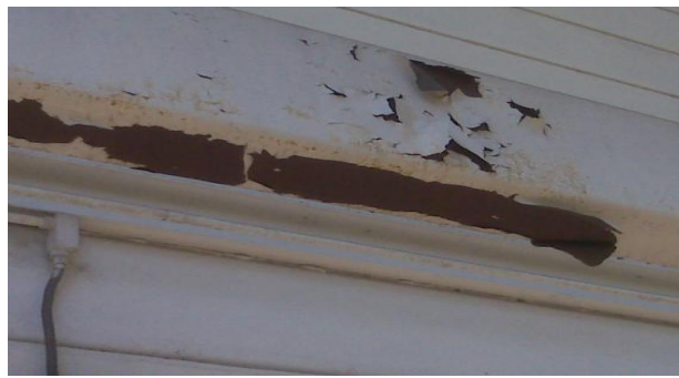
Figura 38. Techo de Biología
