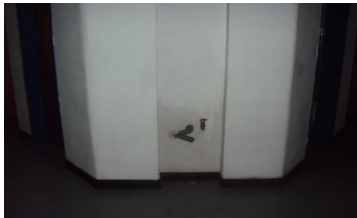
Figura 36. Espacio para bebedero en FE1
