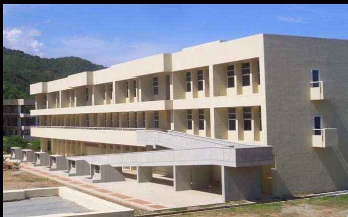
Acceso a las Edificaciones a través de Rampas
