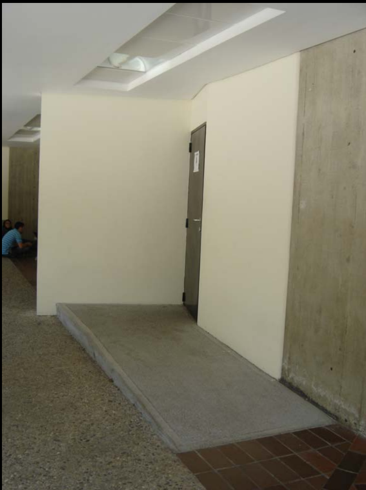
Acceso a Sanitarios a través de rampa en concreto al 10%
